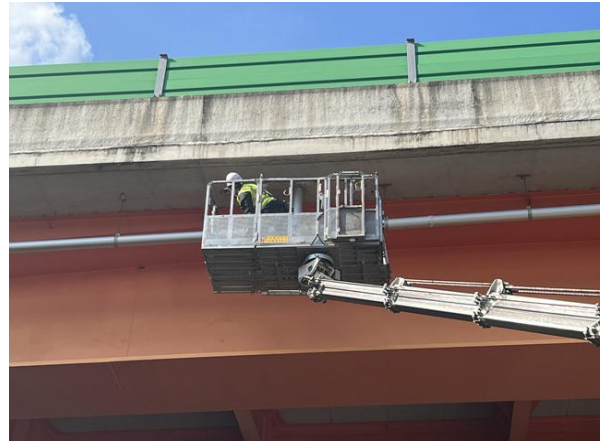
고소점검차를 이용한 근접조사
